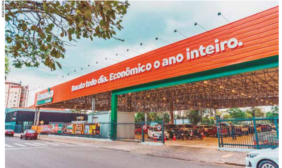
As obras duraram aproximadamente de três meses, período em que a loja permaneceu em funcionamento
